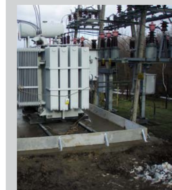
Zdjęcie 2. System ReBund GRC - po zabudowie
